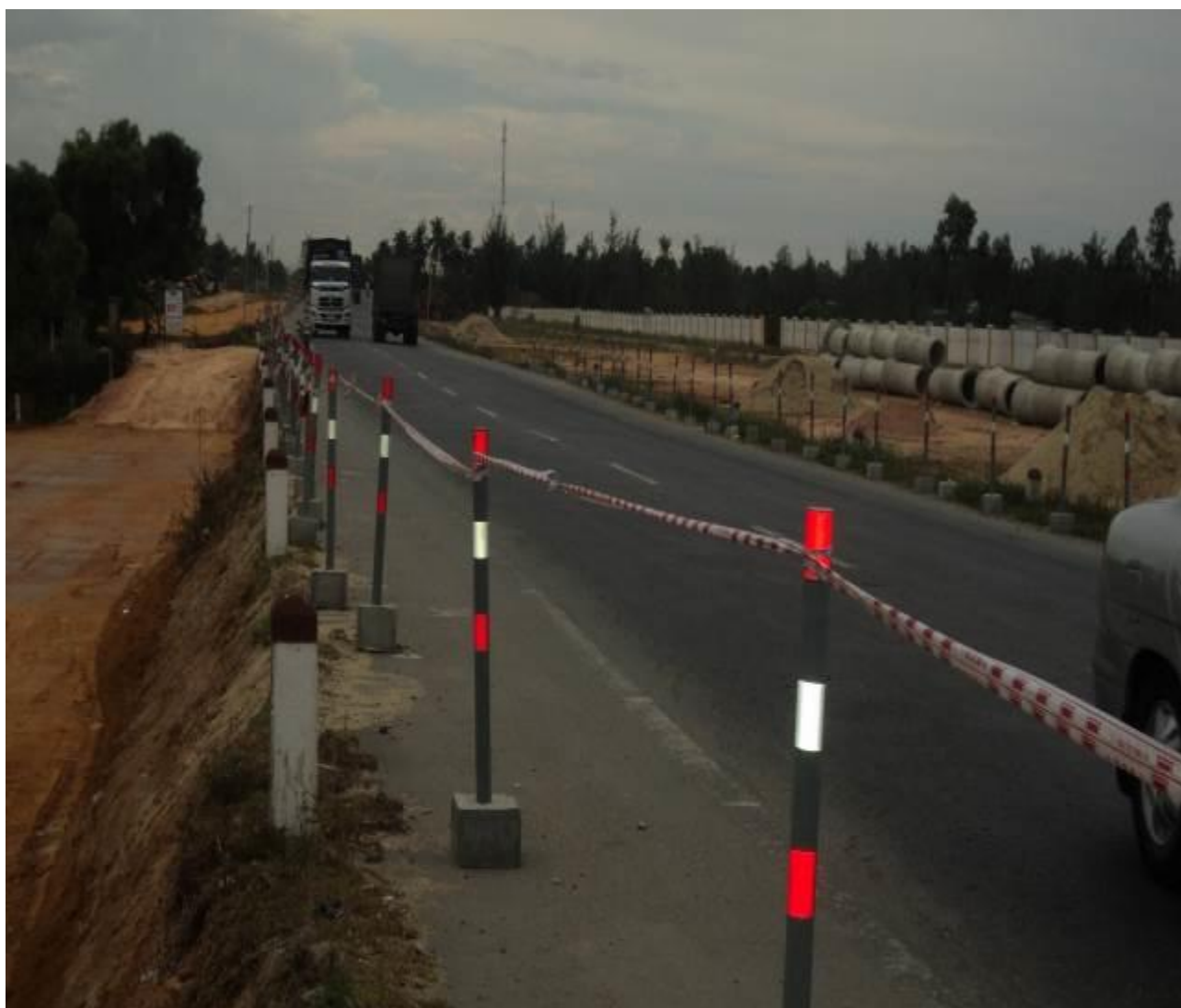
Hiện trường đang thi công mở rộng Quốc Lộ 1 đoạn qua tỉnh Quảng Nam
