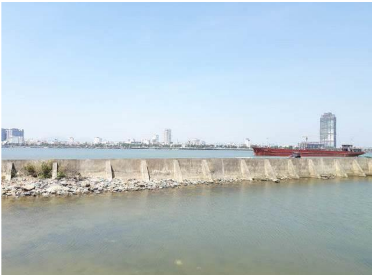
Nâng cấp đê, kè Mân Quang (đoạn nối tiếp đê, kè Bạch Đằng Đông)
