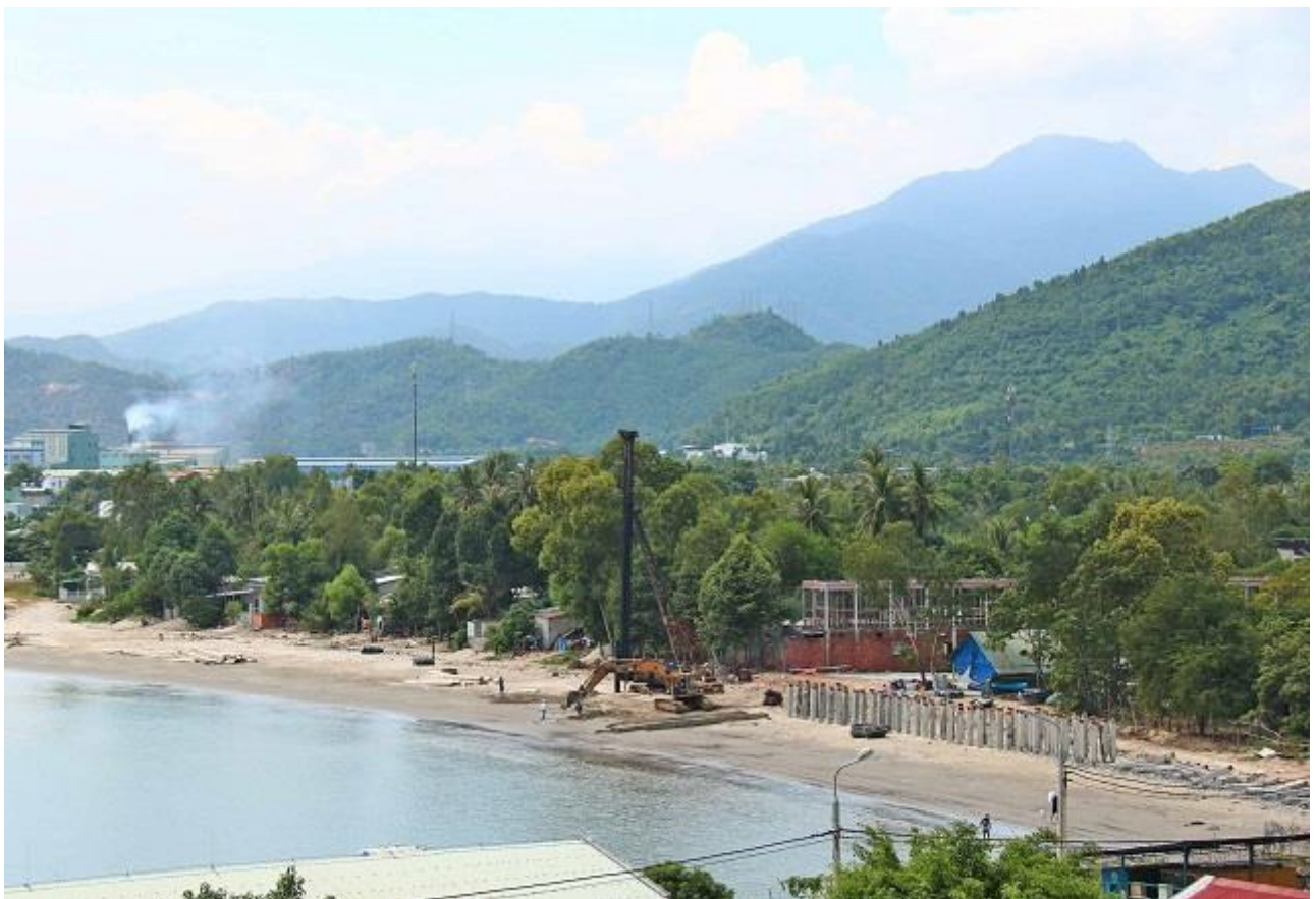
Đê, kè biển Liên Chiểu – Kim Liên, thành phố Đà Nẵng
