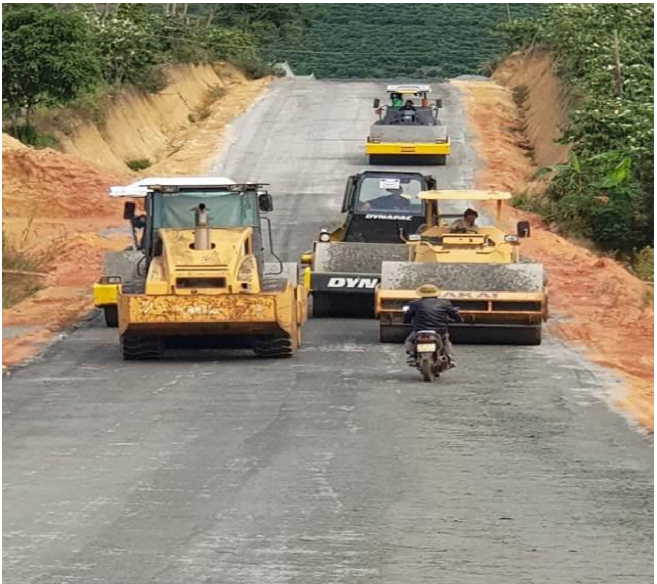
Thi công Tuyến đường ĐT.724, tỉnh Lâm Đồng
