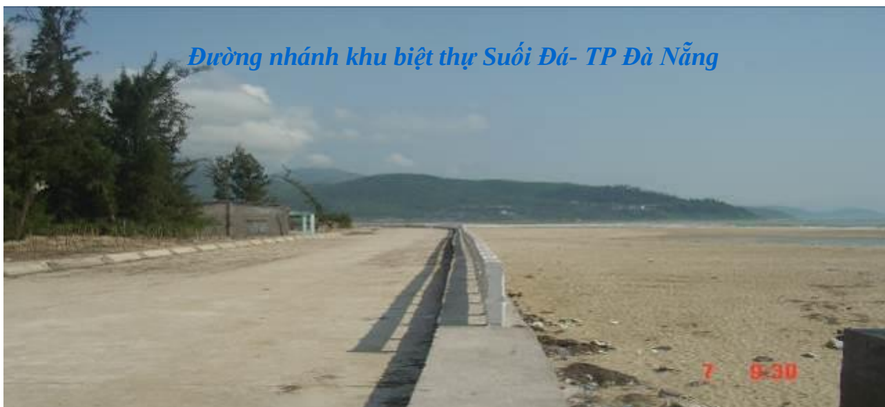
Kè chắn sóng cửa sông CuĐê giai đoạn 1 (tại 1 vị trí có bậc xuống biển)
