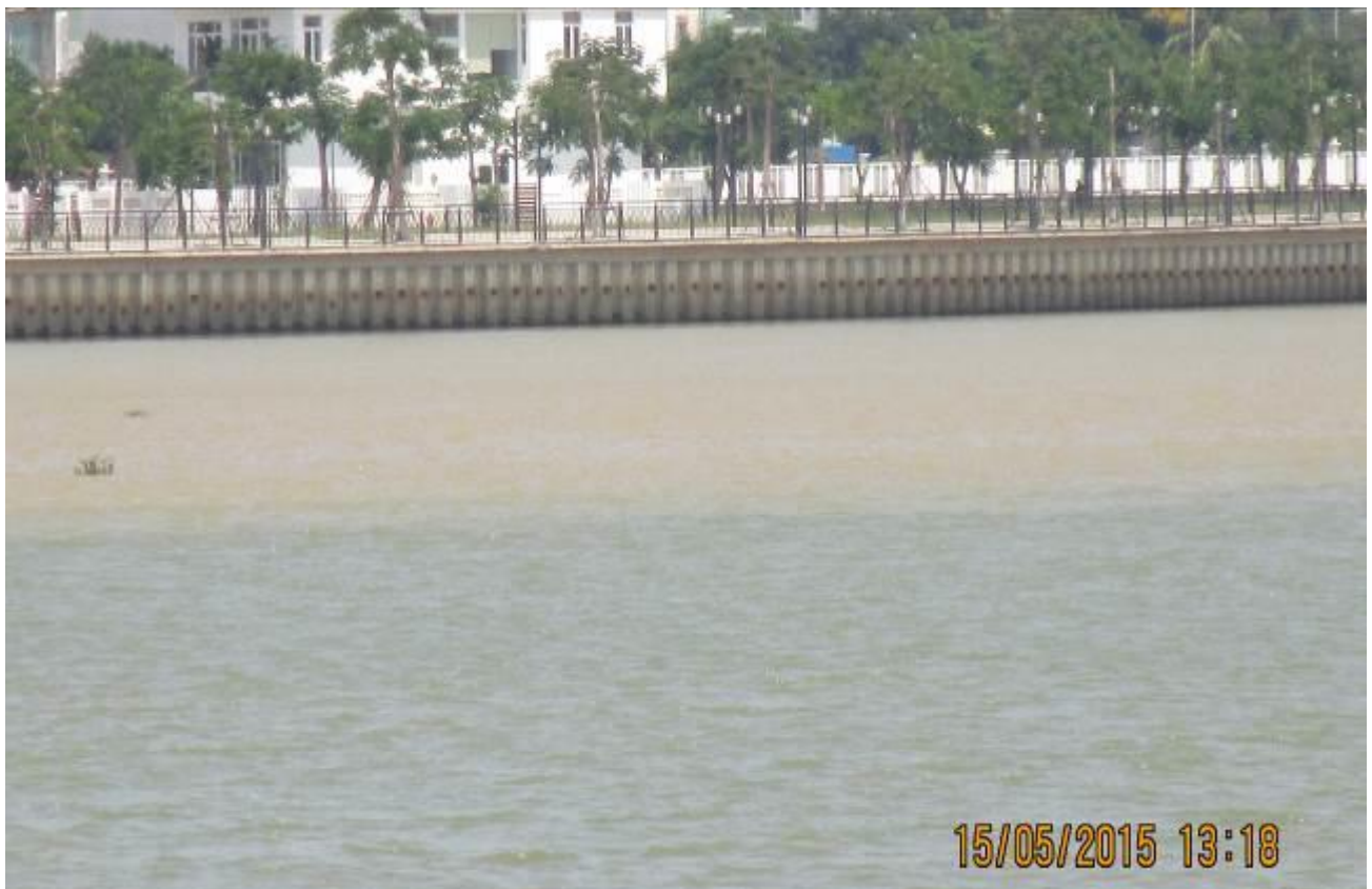
Nâng cấp đê kè vùng cửa sông Hàn (đoạn từ Cổ Viện Chàm đến công ty Sông Thu)
