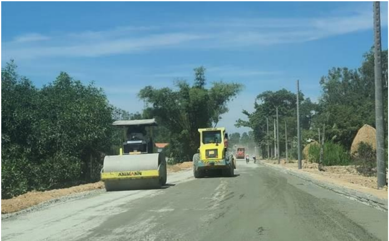
Thi công Quốc lộ 40B, tỉnh Quảng Nam
