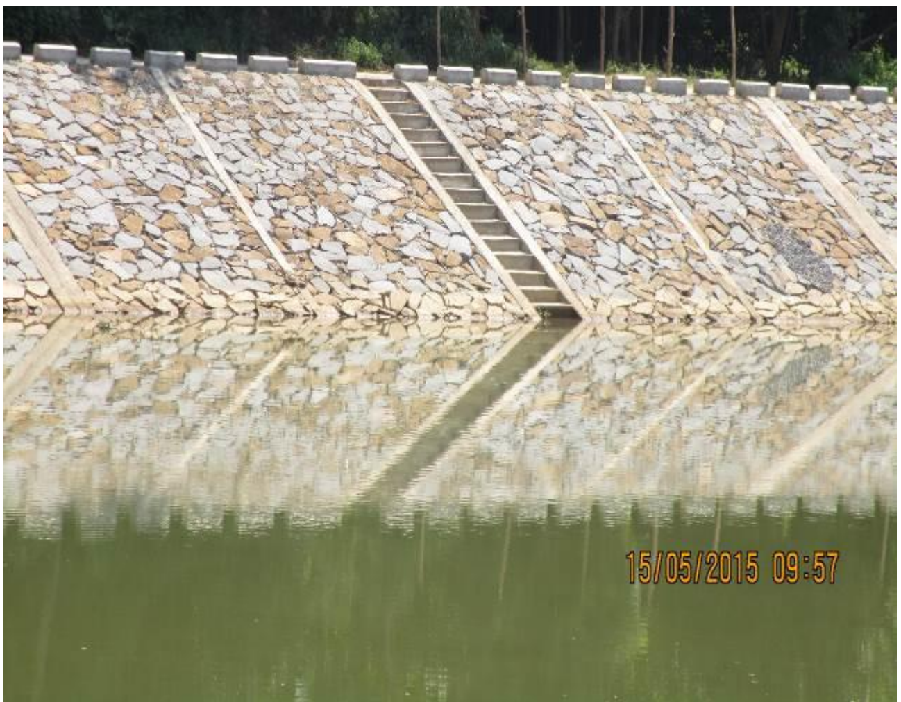
Kè bảo vệ bờ sông Vĩnh Điện, đoạn qua khu dân cư Bá Tùng (giai đoạn 2)
