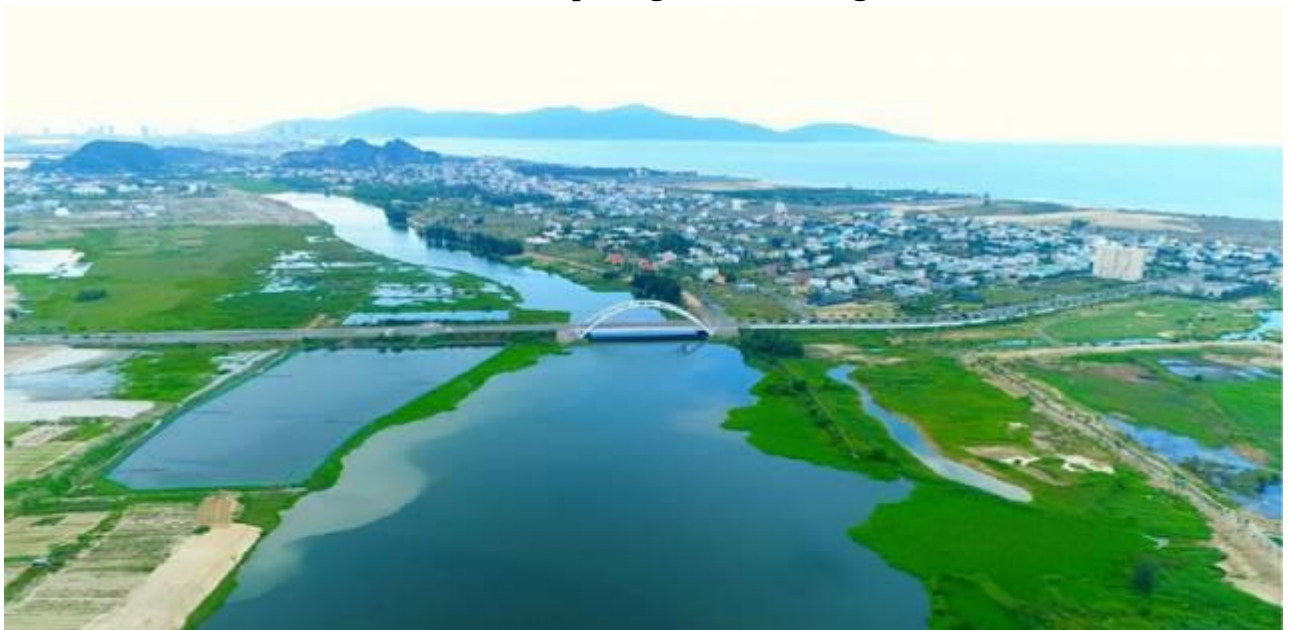
Dự án nạo vét, khơi thông sông Cổ Cò, thành phố Đà Nẵng
