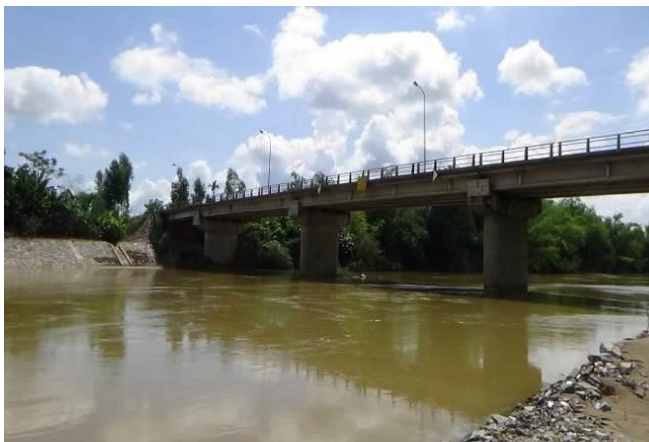
Cầu Sông Yên – Dự án ADB5
