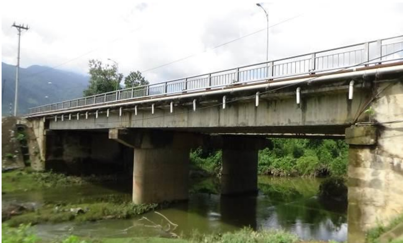
Cầu An Lợi – huyện Hòa vang – TP. Đà Nẵng.
