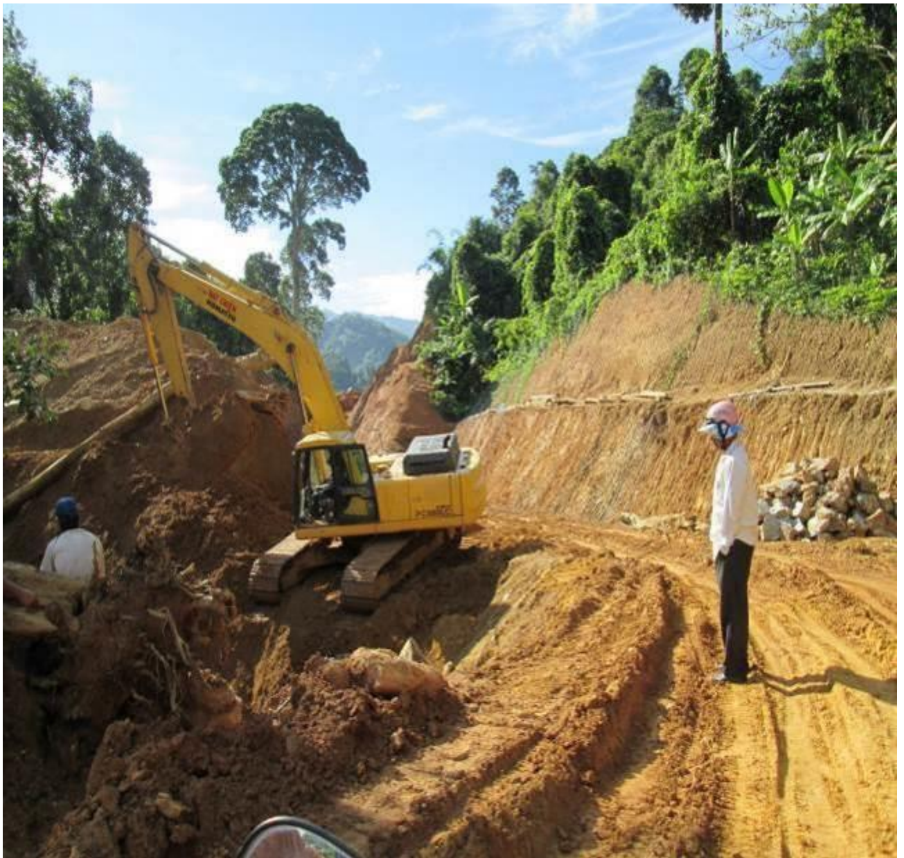
Hiện trường thi công đường Tây TắcPỏ - Nam Trà My, Quảng Nam
