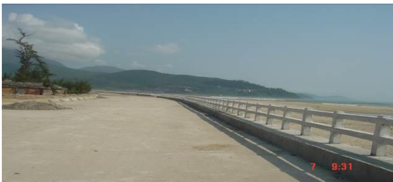
Đoạn đầu của kè chắn sóng cửa sông CuĐê giai đoạn 2
