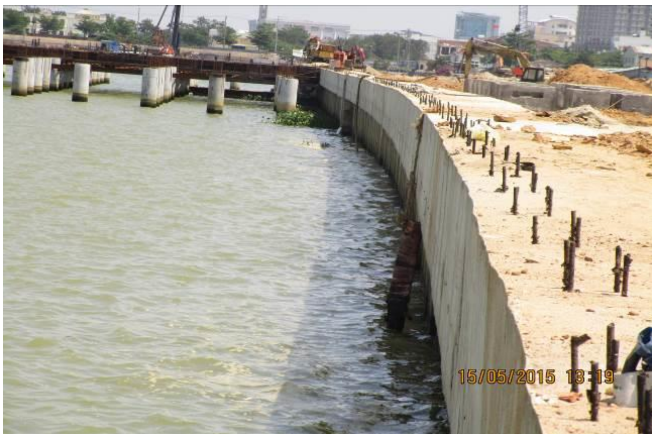
Nâng cấp đê kè vùng cửa sông Hàn (đoạn từ công ty Sông Thu đến đường dẫn lên cầu Nguyễn Văn Trỗi)
